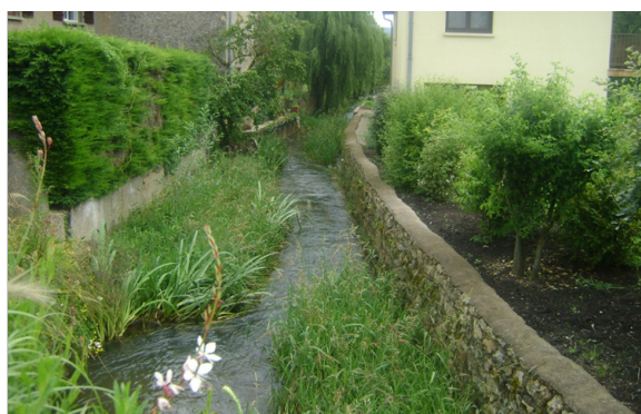
Renaturation fond du lit du Trey par banquettes végétalisées dans la partie amont de la traversée de Vandières
