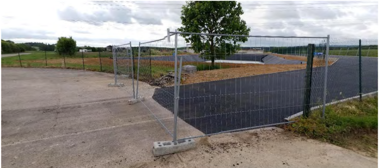
Photo 1 : vue de l'entrée du site par la RD 120
