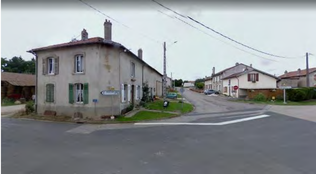
L'homogénéité du front bâti Rue des Dames
