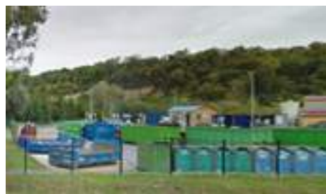
Déchetterie communautaire basée à Pont-à-Mousson, Route Vandières.
